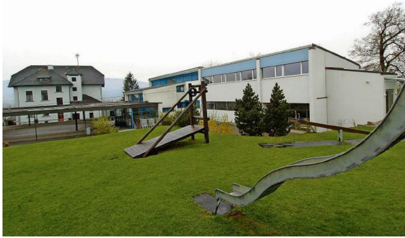
Die Winznauer Schulanlagen sollen inskünftig mit Gas beheizt werden.
