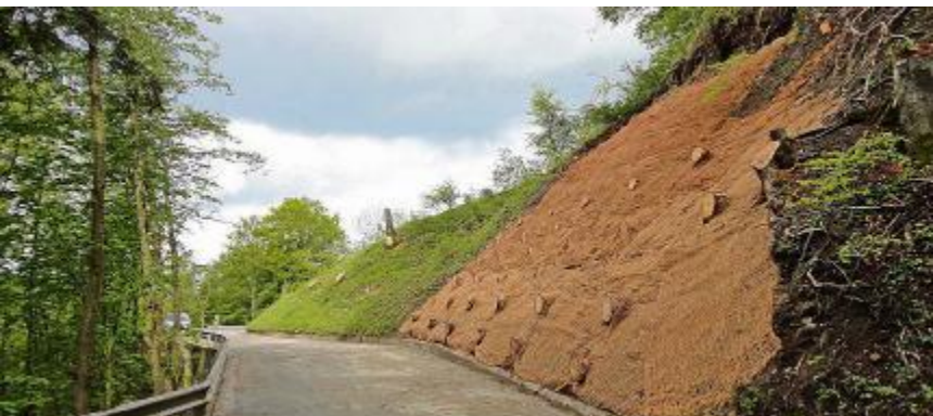
Die Aufnahme zeigt den verbauten Hang.
