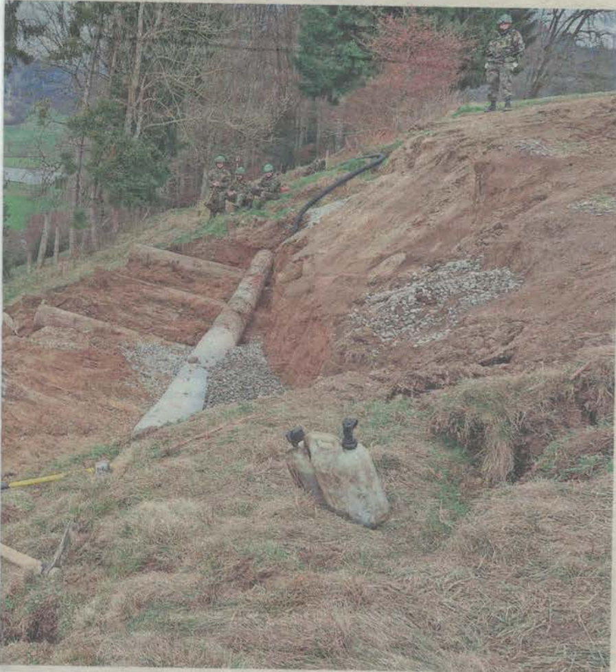
werden im «Gallihubel»-Gebiet in Bottenwil Sicherungselemente eingebaut.
