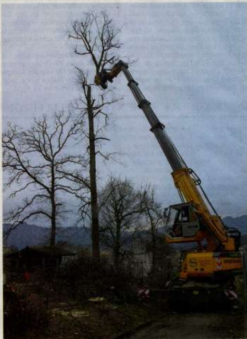
Auch mit dem Fällkran wird zu Werke gegangen.
